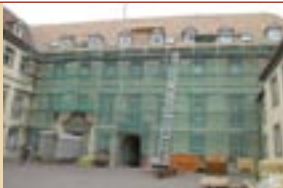
Die Fassade des Bischöflichen Generalvikariates wird renoviert.
