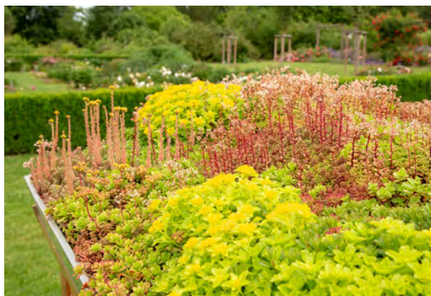
Beispiel für eine extensive Dachbegrünung auf dem Dach eines Geräteschuppens.
