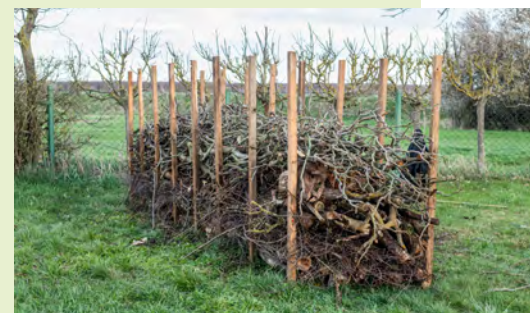
Aufbau einer Totholzhecke.
