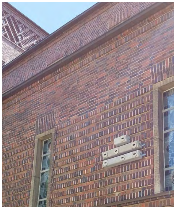
Kirche St. Heinrich in Hannover – Nistkästen am Durchgang nördlich der Kirche.
