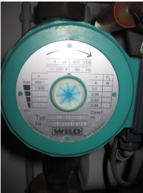
Mehrstufig unregelte Pumpe
